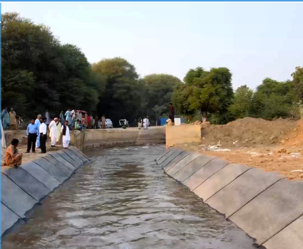
Завершённый участок канала
