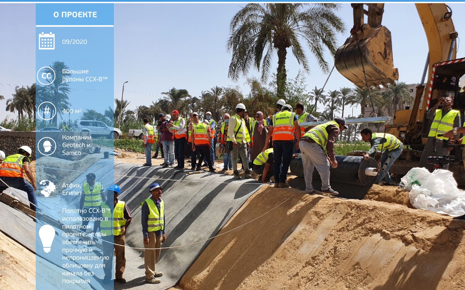
CCX-B™ был доставлен на место с помощью экскаватора, оснащенного траверсой
