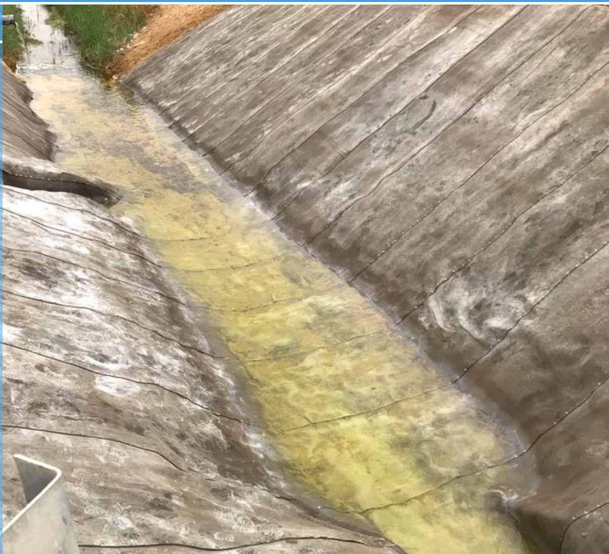
Завершенный участок канала после гидратации
