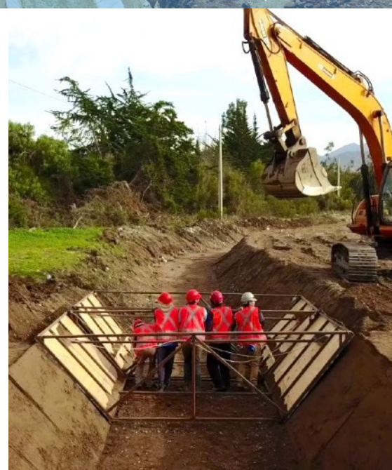
Профилирование канала перед монтажом CC5™
