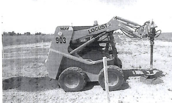
Подготовка посадочных ям при помощи ямобура
