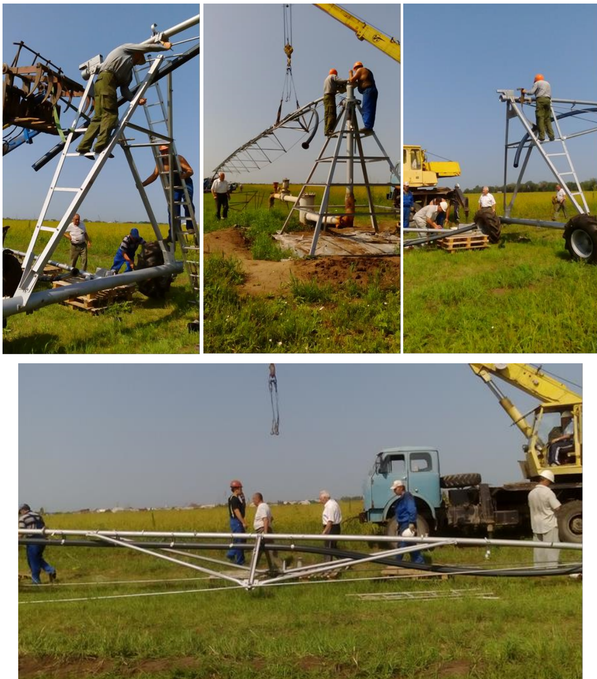
Монтаж пролета опытного образца ДМ ферменной конструкции
